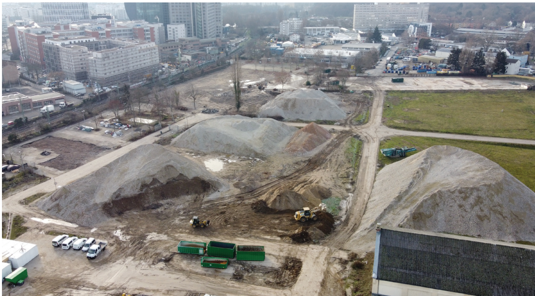
Schönhof-Viertel (Siemensstadt) süd. Rödelheimer Landstraße – Vor 25 Jahren sollte hier Wohnraum entstehen, jetzt rollen endlich die Bagger.
